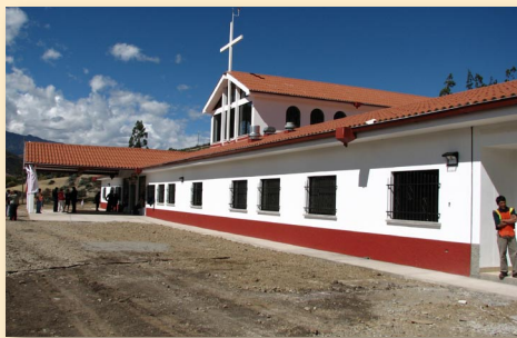
▲ Todavía falta la pavimentación.
