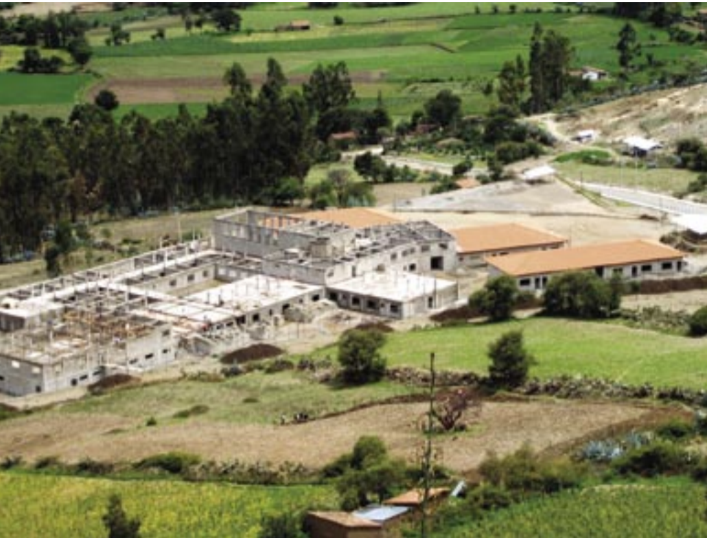
Vista del hospital en construcción, diciembre 2006
