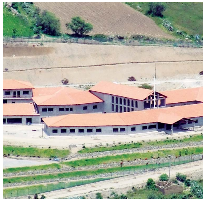
Die Baustelle Ende Februar 2007
