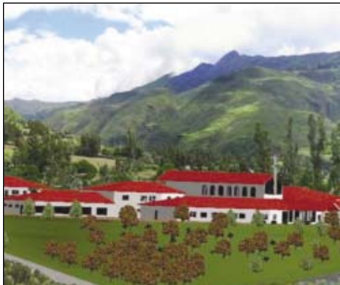
In der Armengegend Curahuasi entsteht das Krankenhaus.
